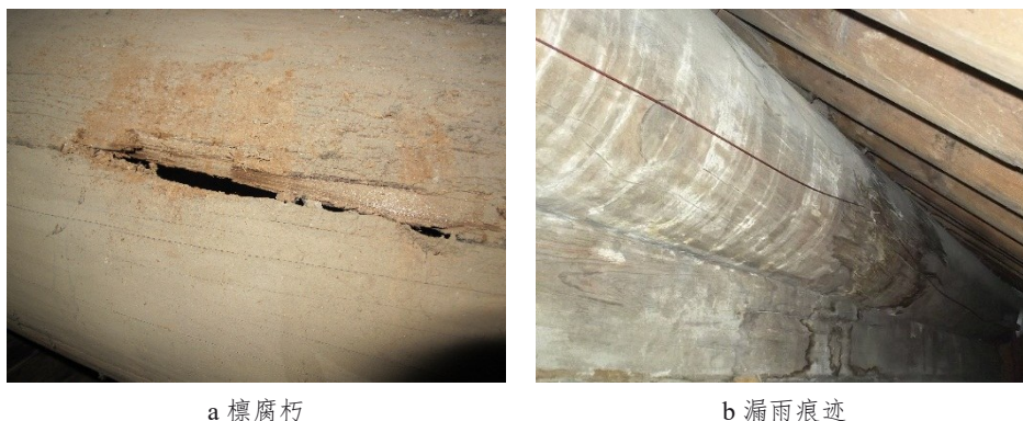
图5 木构件的腐朽
