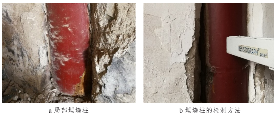
图4 埋墙柱及探测方法
