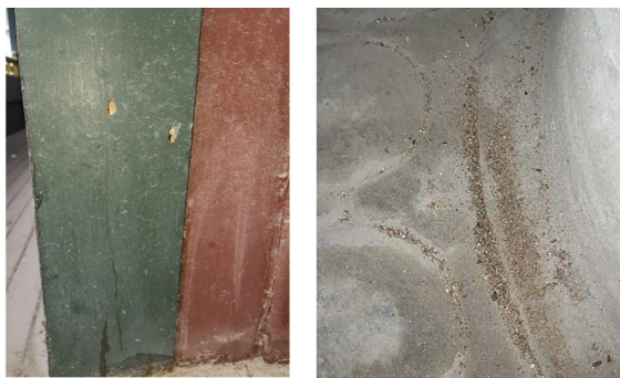
图6 木构件蛀孔及蛀屑
